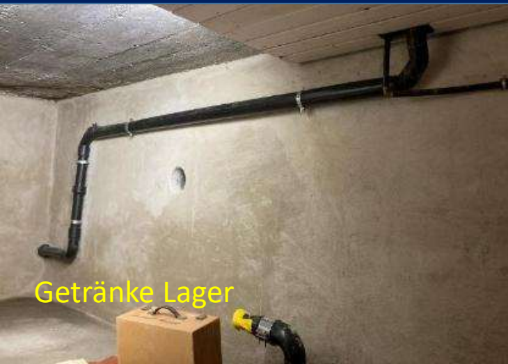
Alle Wände neu Verputzt und Bestehende Löcher geschlossen
